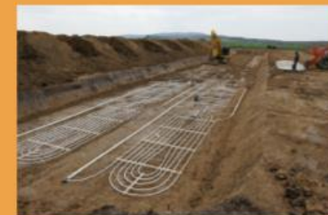
Verlegung von Deutschlands größtem Kollektorfeld im Baugebiet Bad Nauheim
