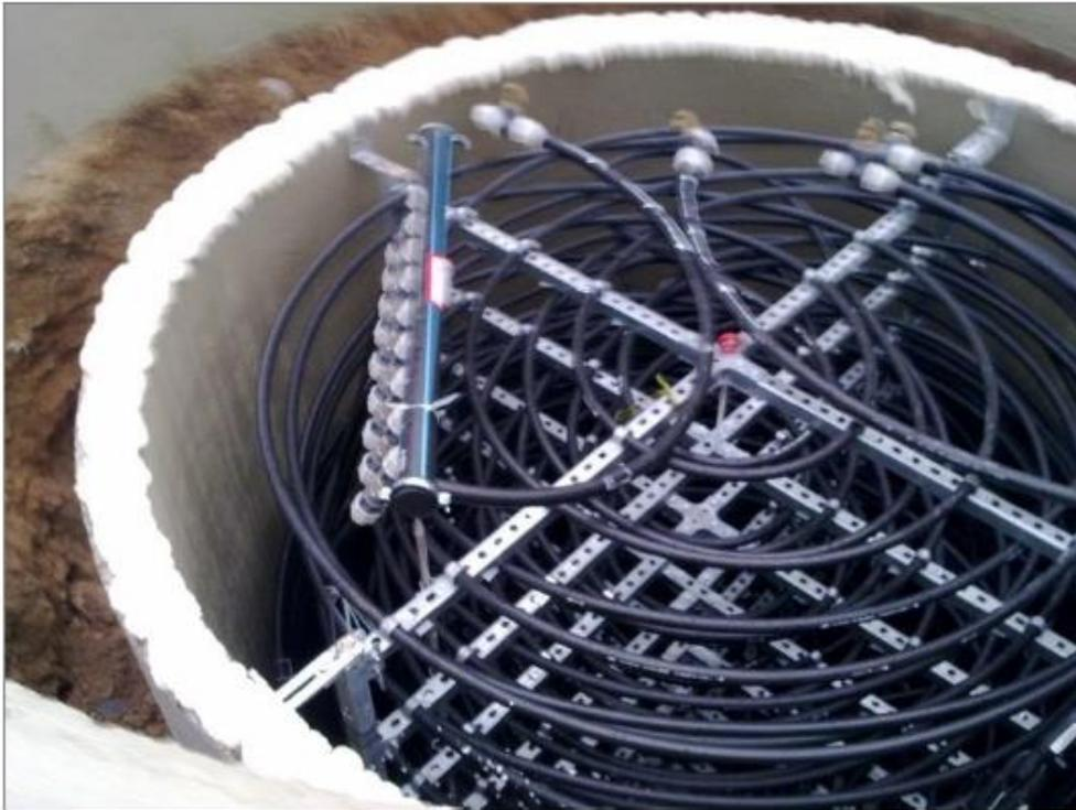
Projekt zur Förderung eines großen Eiswärmespeichers in Kombination mit Wärmepumpe und Solarkollektorfeld zur Versorgung eines Wohnquartiers in Friedrichsdorf.
