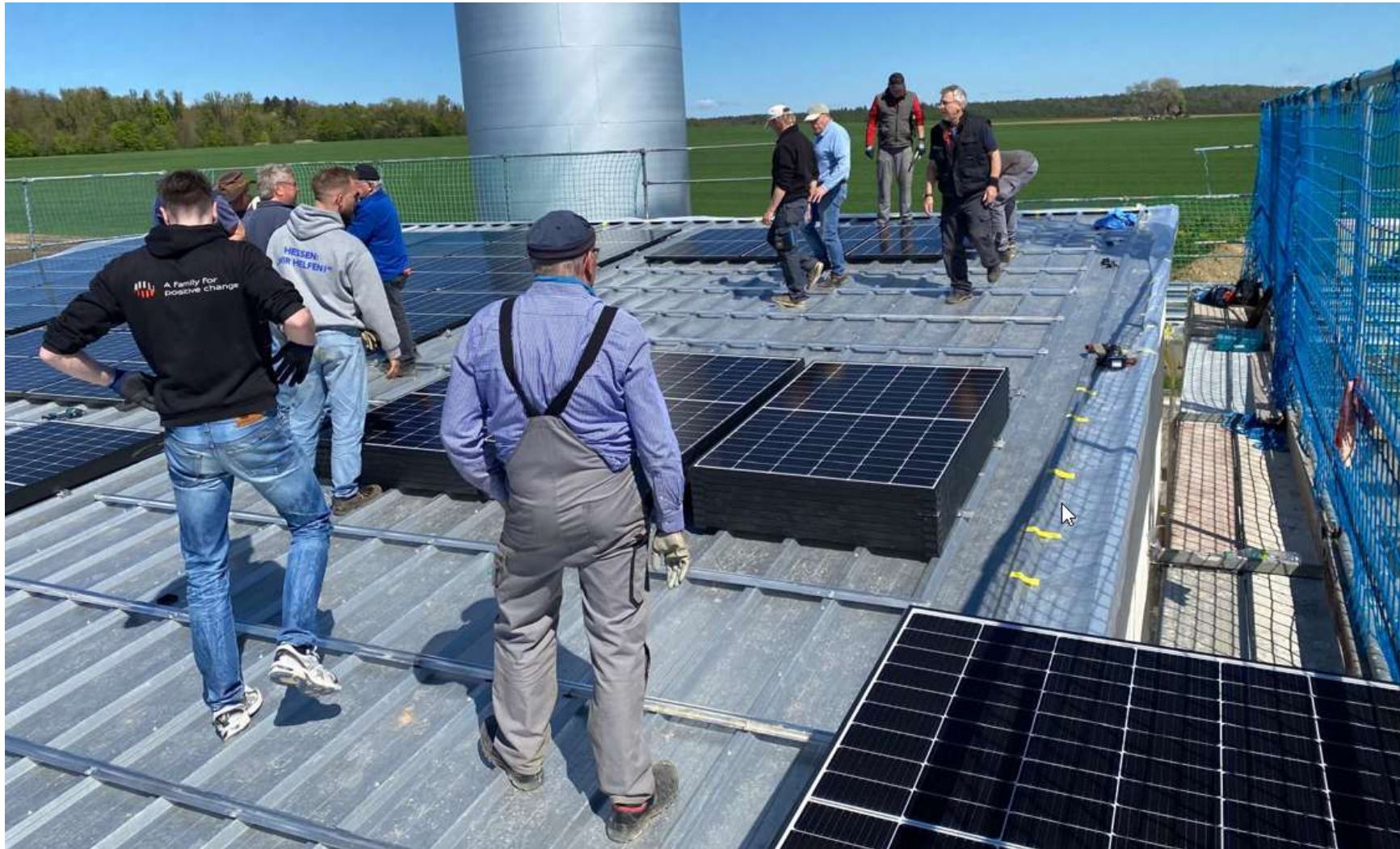
Mai 2025 – Installation der PV-Anlage auf dem Heizhaus
