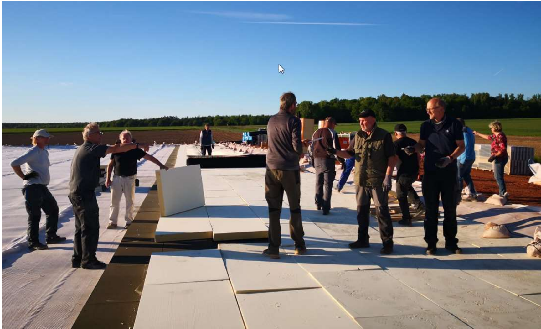
Mai 2025 – Beginn Verlegung der Dämmplatten auf dem Speicher
