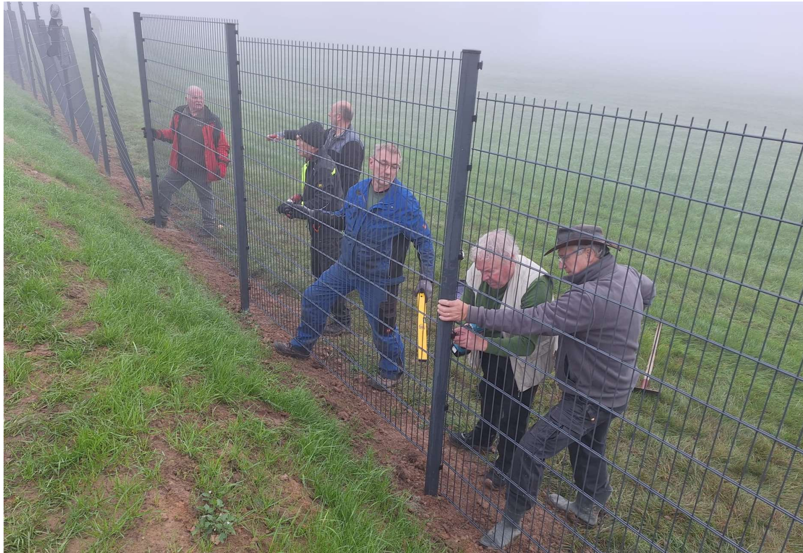
November 2024 – Installation der Zaunelemente
