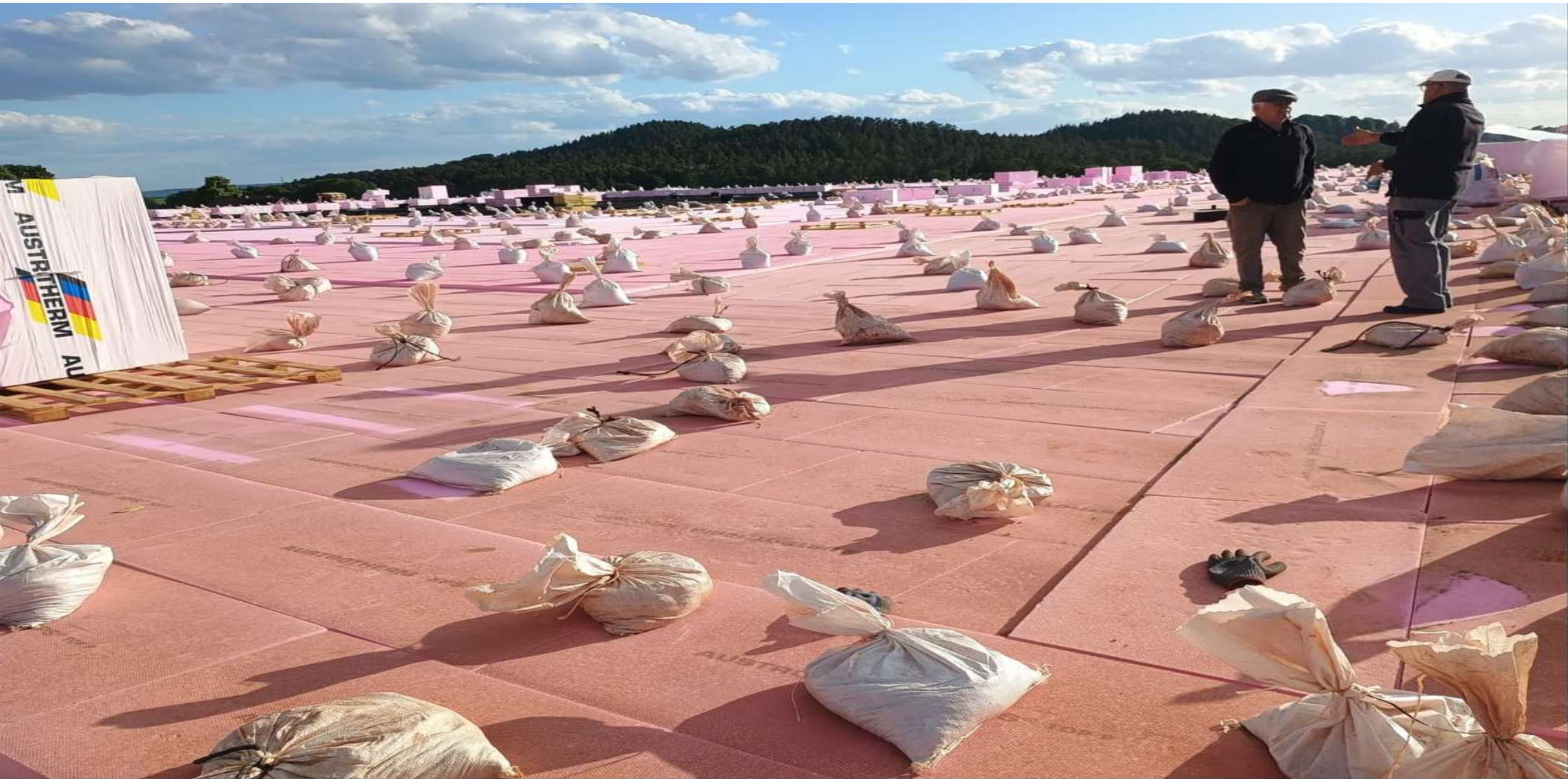
Aufbringung letzte Dämmlage => XPS Platten mit Stärken von 3 bis 22cm. Treppenartiger Aufbau zur Erstellung Gefälle zur Wasserabführung.
