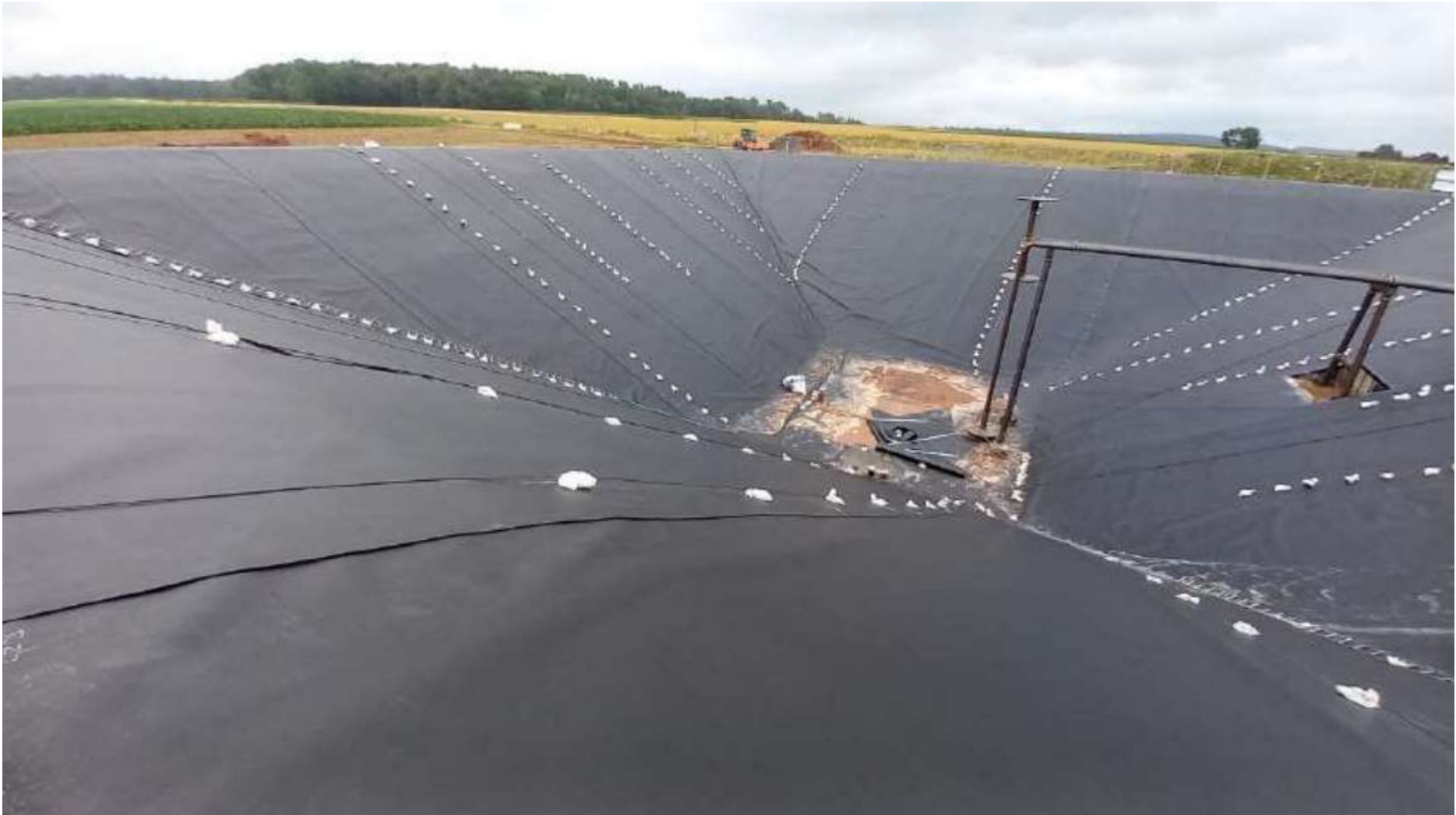
Juli 2024 – Auskleidungsarbeiten beendet, kurz vor Beginn der Befüllung
