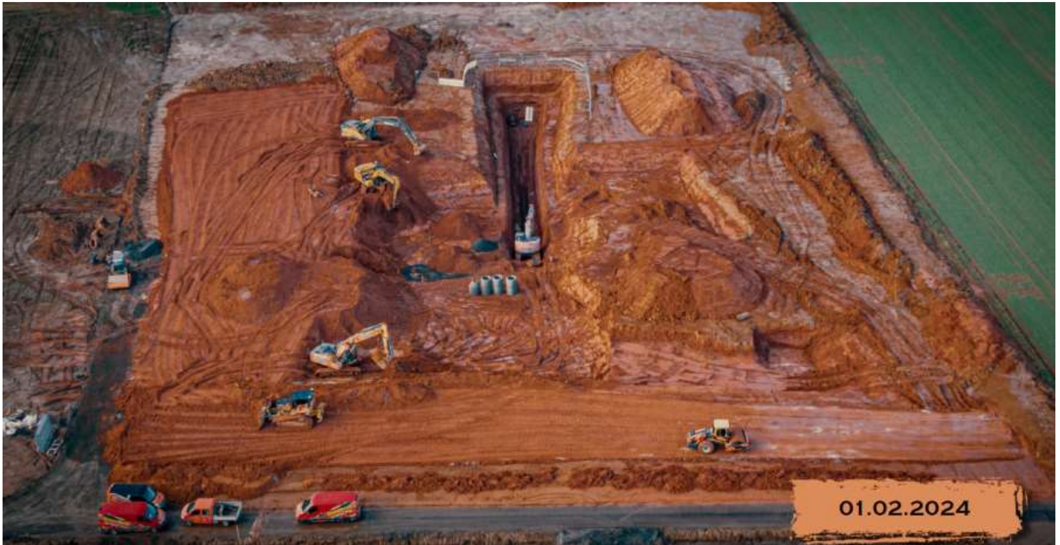
Februar 2024 – Die groben Umrisse des Speichers werden erkennbar
