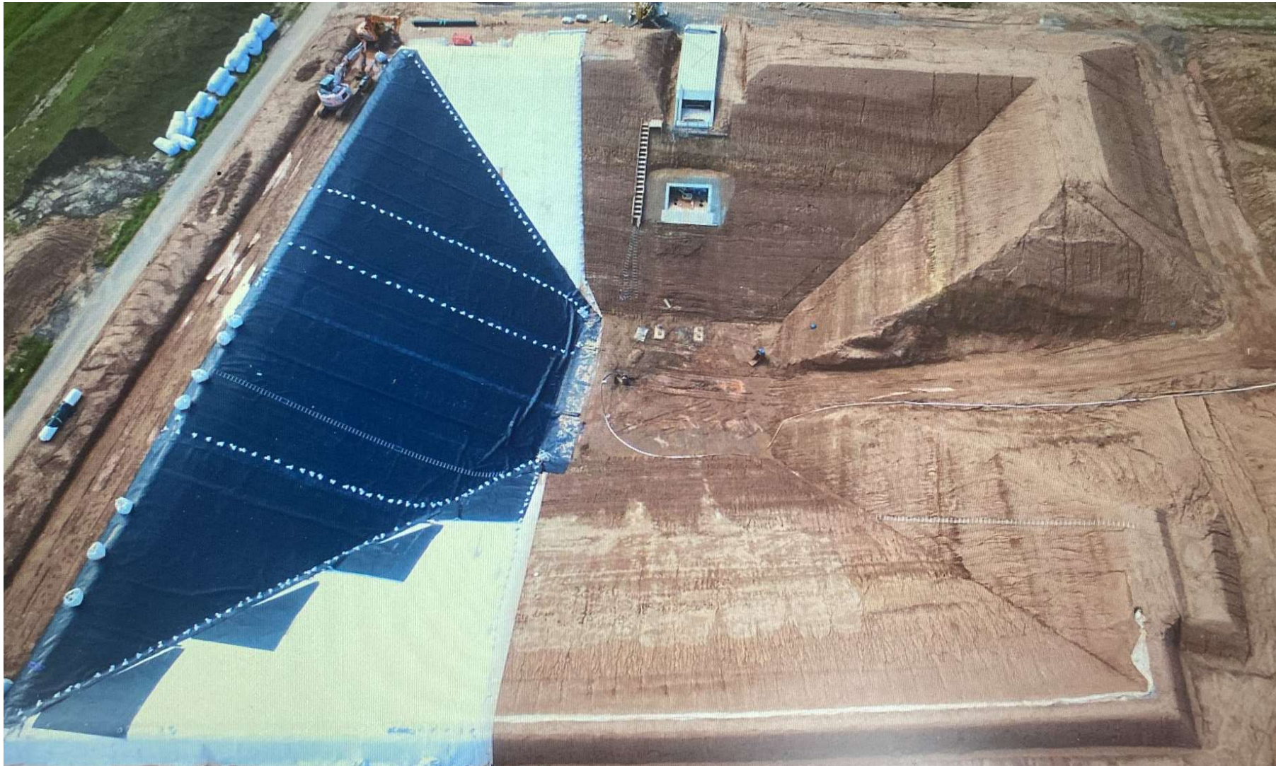
Mai 2024 – Beginn der Auskleidungsarbeiten
