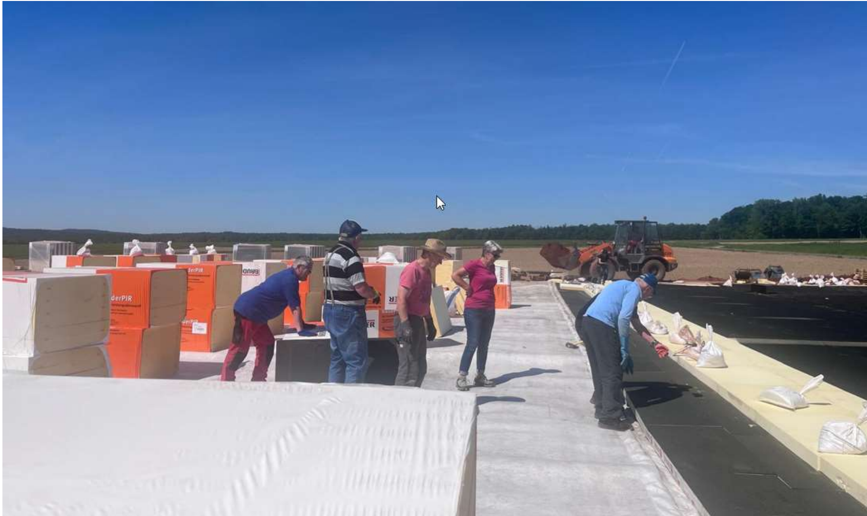
Mai 2025 – Fortsetzung der Arbeiten am Speicherdeckel
