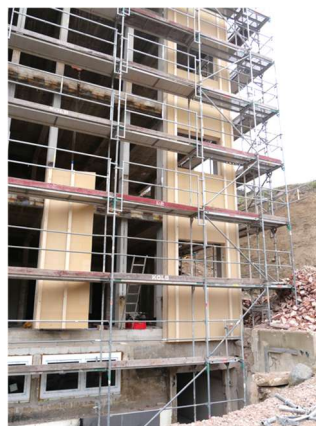
Montage der Außenelemente April 2025
