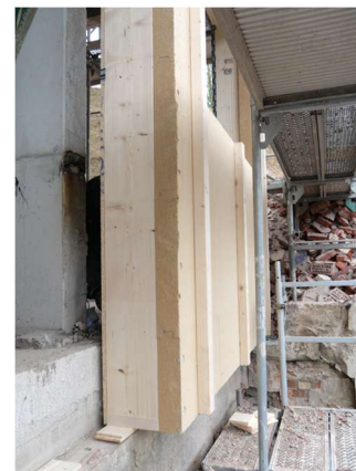
Montage der Außenelemente April 2025
