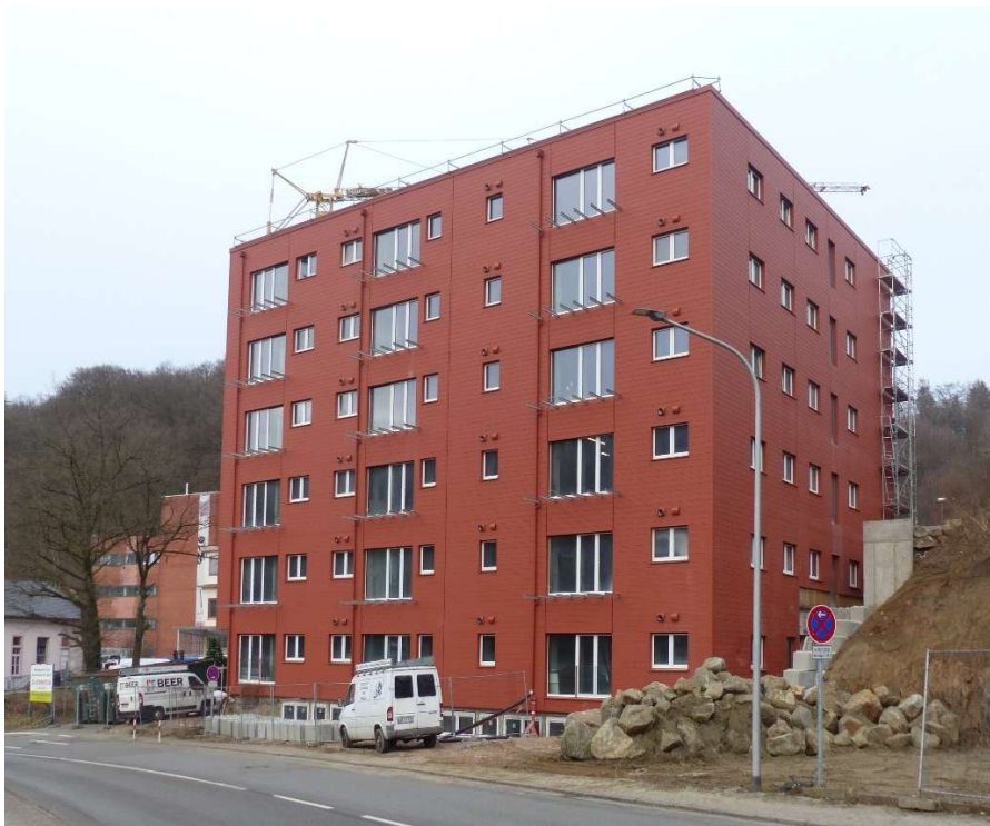
Februar 2026 vor Montage der Balkone
