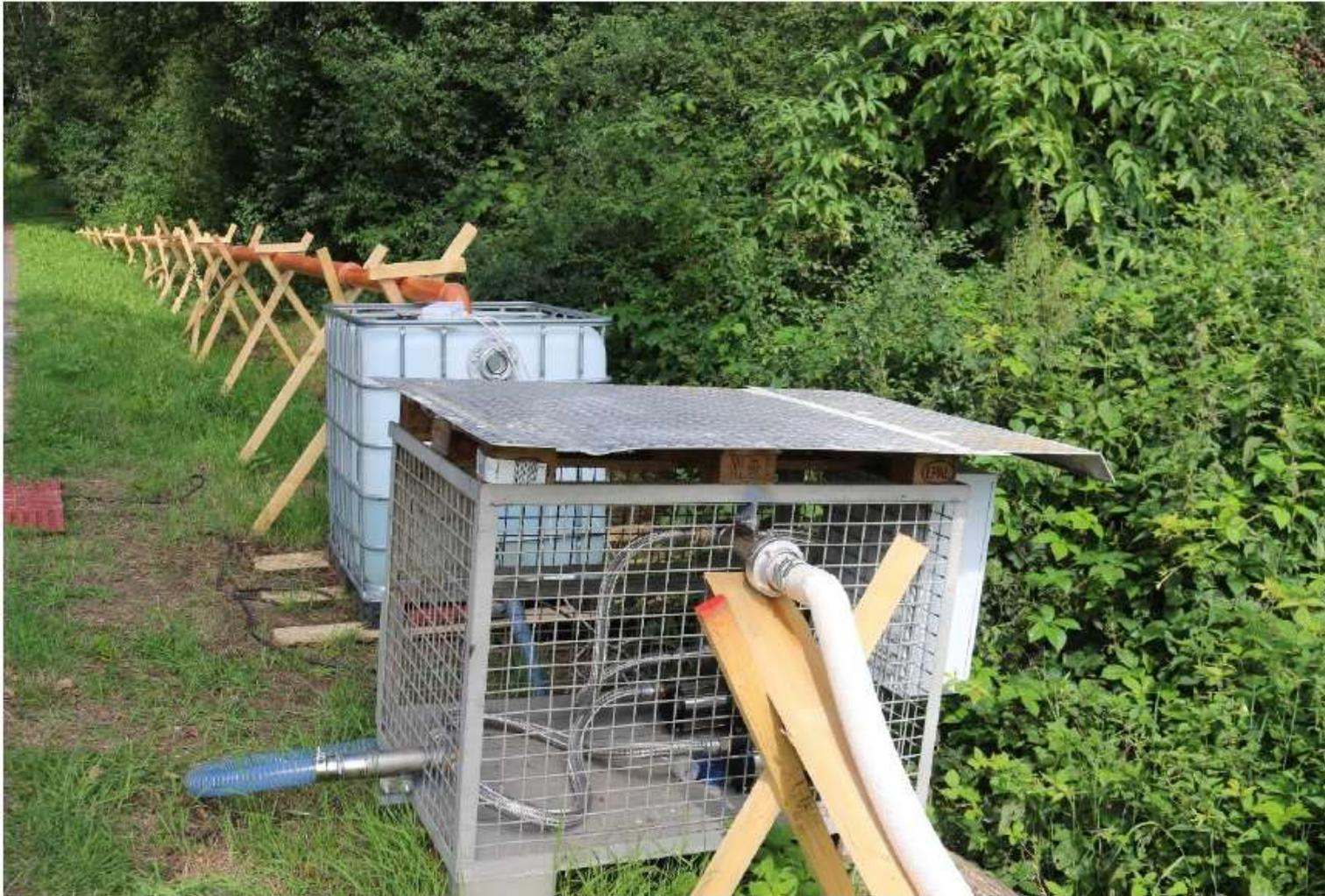
5,8.2024 Wasser vom Brachter Hochbehälter. Das Wasser kommt über den Überlauf, fließt in einen Pufferspeicher und wird per Feuerwehrschräuchen etwa 1,3 km weit zur Mehrzweckhalle transportiert.
