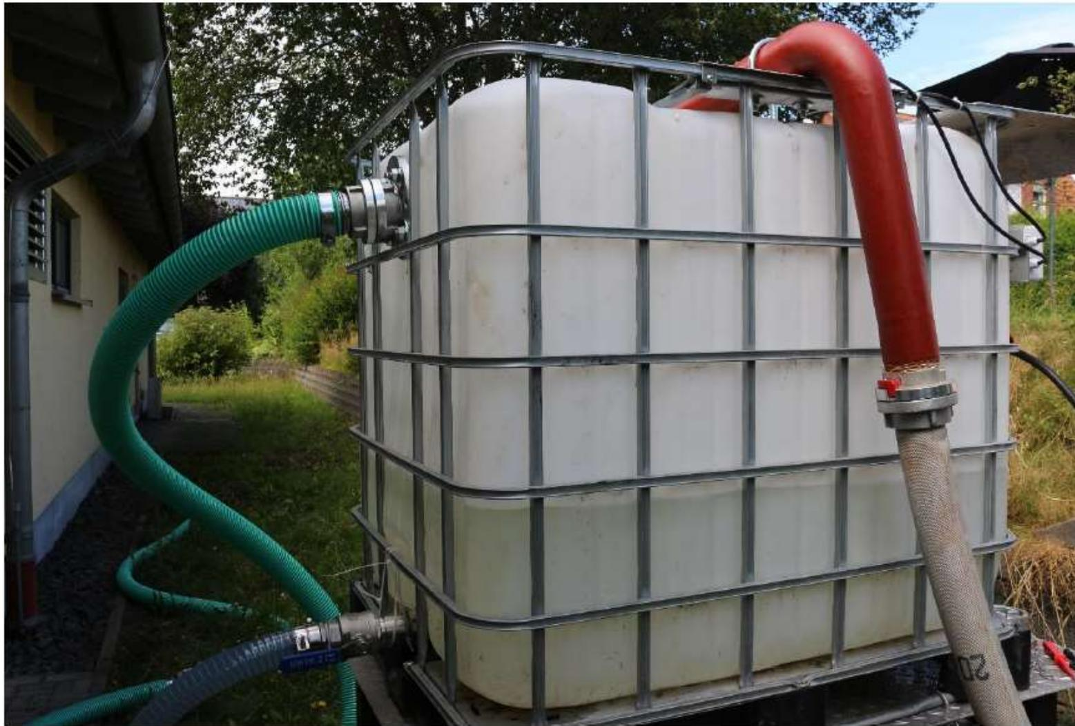
5.8.2024 Zweite Pumpe. Das Wasser vom Hochbehälter fließt in einen zweiten Pufferspeicher und wird über die 1,4 km lange spätere Haupttransportleitung zum Speicher gepumpt.
